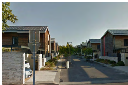
Exemple d'une voirie de quartier : végétalisation, ambiance apaisée -St Priest (69)
